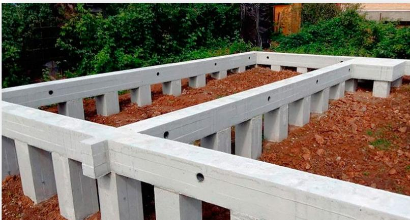
подготовка ямы (скважины); монтаж опалубки; сборка арматурного каркаса; заливка бетона.
