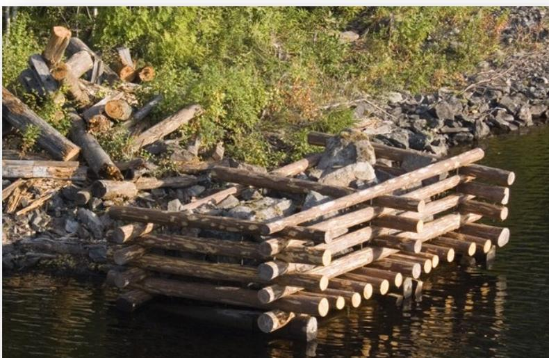
Для устройства сооружений на местности, покрытой водой, включая и опоры мостов, в качестве опор и оснований применяли ряжи, т.е. конструкции из перекрестных деревянных бревен или брусьев. Ряжи устраивали в виде клеток с небольшими ячейками, снабженными
