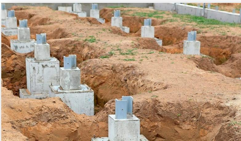
Сборные столбчатые фундаменты представляют собой столбы и бетонные платформы, изготовленные на заводе
