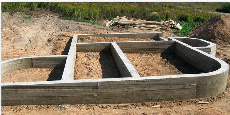
Замешанный непосредственно на участке или готовый (с завода) бетон заливается в опалубку за один день до полной высоты фундамента. Так достигается необходимая прочность и водонепроницаемость основания. Многие частные застройщики
